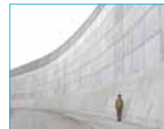
防波壁の設置
