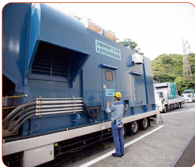
高圧発電機車
