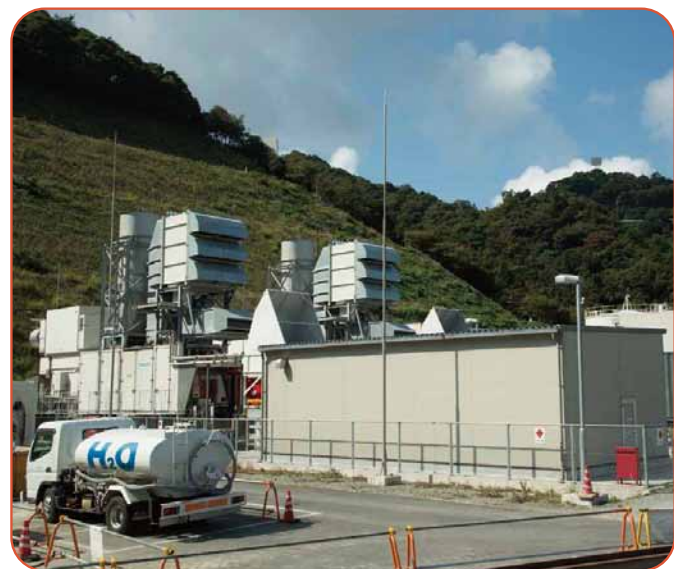
非常用のガスタービン発電機
