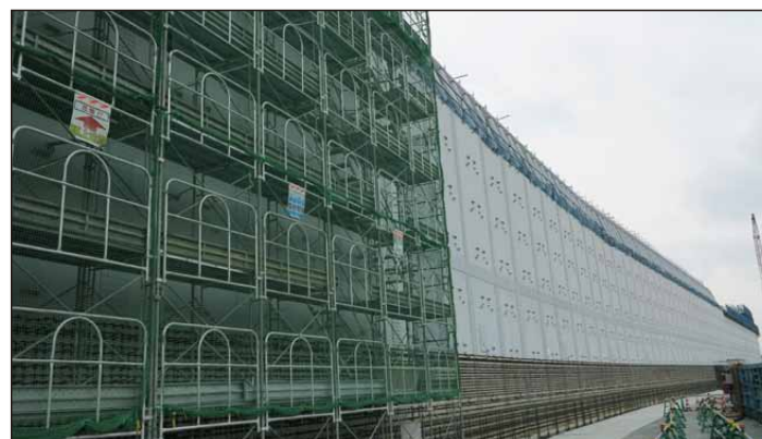
海拔22mの防波壁 浜岡原子力発電所(静岡県)
