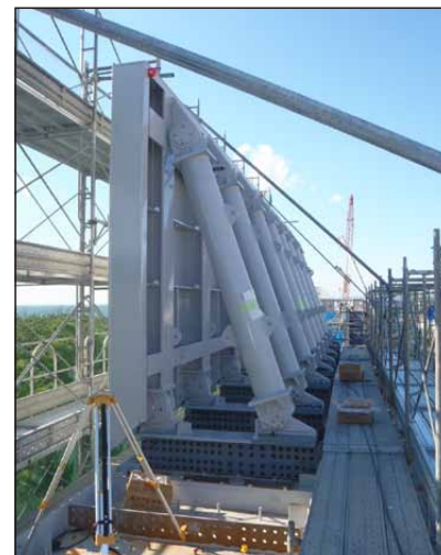
防波壁の設置工事 浜岡原子力発電所(静岡県)
